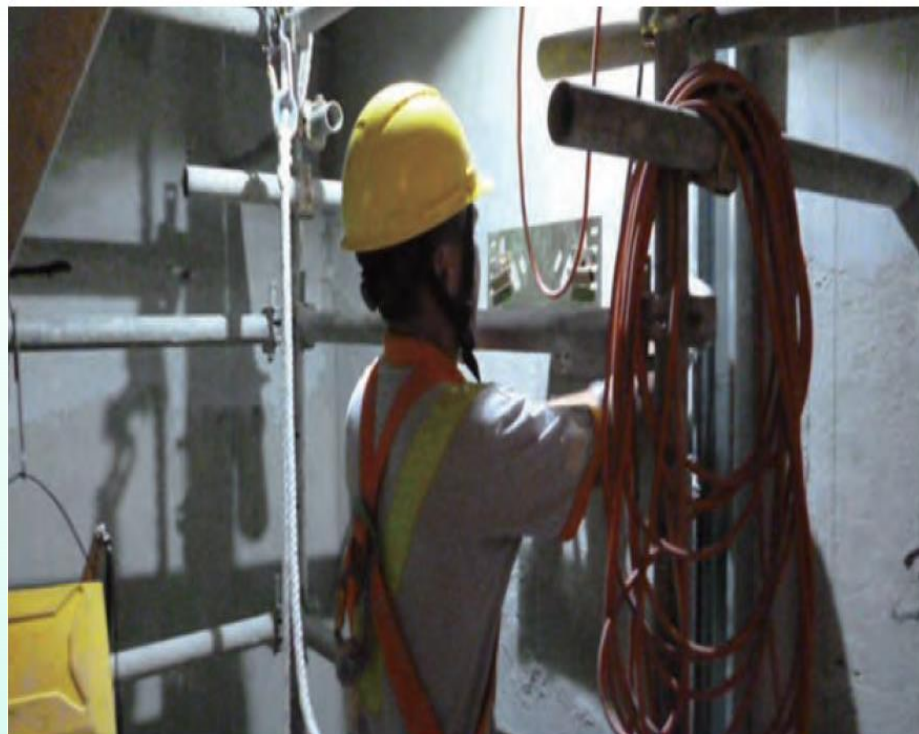
全身式安全吊帶需掛在升降機槽內的救生繩
