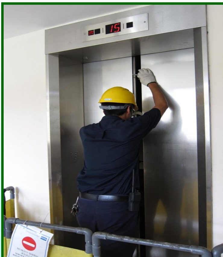
核實工作點層站門聯鎖(不多於90毫米)
