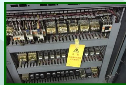
警告标志放置在控制面板及可控制慢车模式的位置
