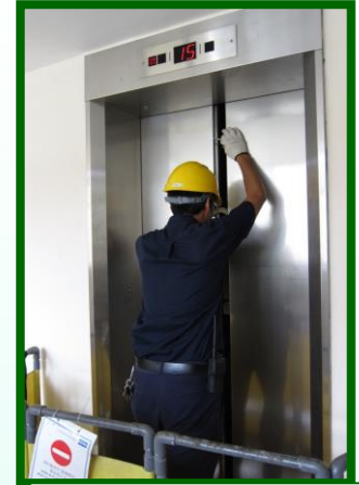
核实工作点层站门联锁 (不多于90毫米)
